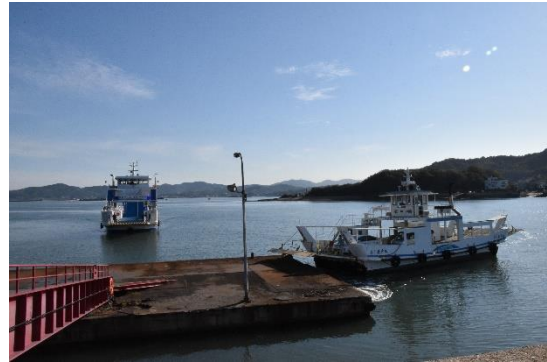
⑥ 歌戸渡船と備後商船は、歌港で同じポンツーンを使っていました。左が備後商船の「百風」、右が「第1歌戸丸」です。
